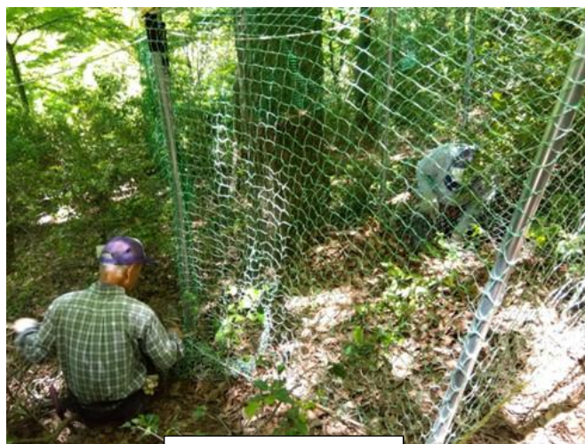
防鹿柵の設置
